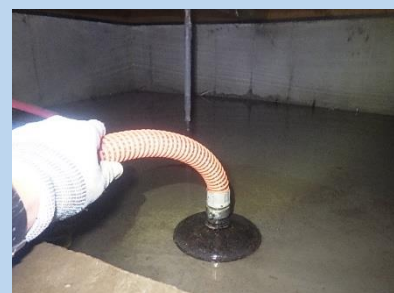
水中ポンプによる水抜き
