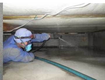
床下への薬剤処理
